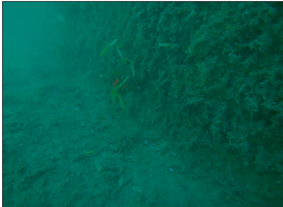
Foto junta de viga de atado con muelle de hormigón en masa TRAMO 3
