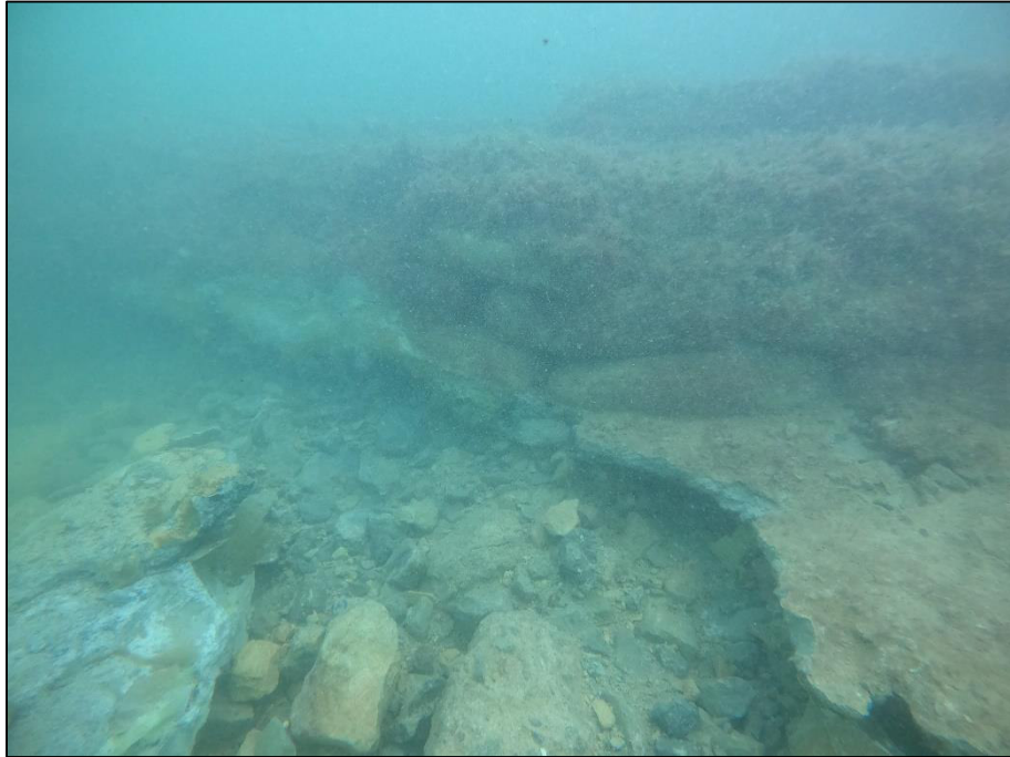
Foto N°10 Descalce en TRAMO 10
