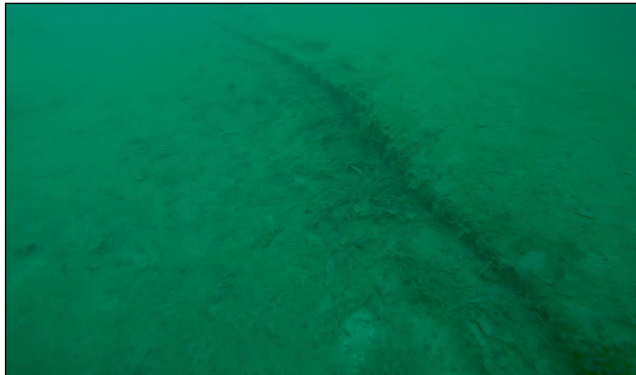
Foto de sedimento sobre base de pieza en “L” y viga riostra TRAMO 4
