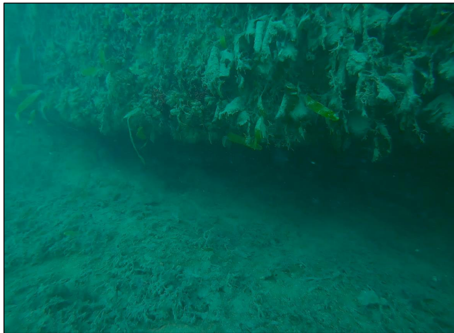
Foto de coquera sobre viga de atado superior TRAMO 5
