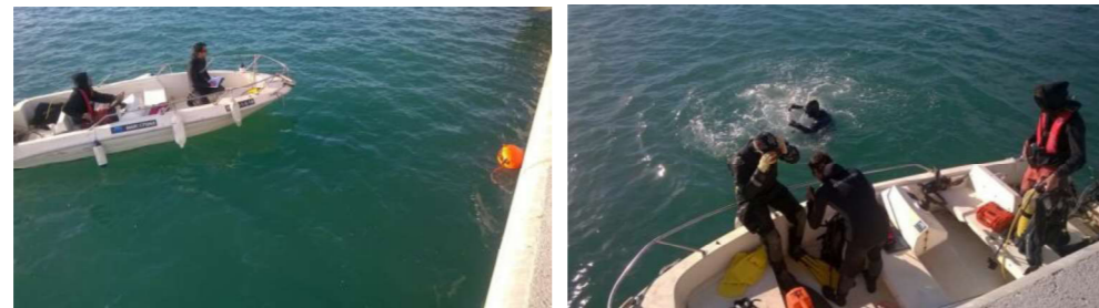
Figura 10. Submarinistas durante la realización de los trabajos de inmersión en el Puerto de Eivissa.
