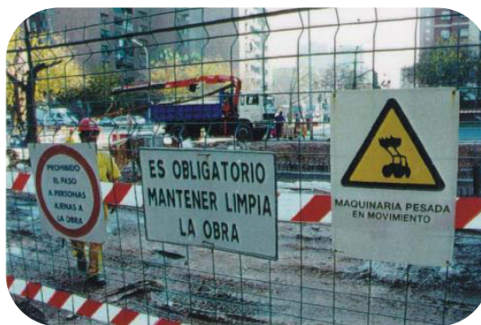
Señalización en zona de obras
