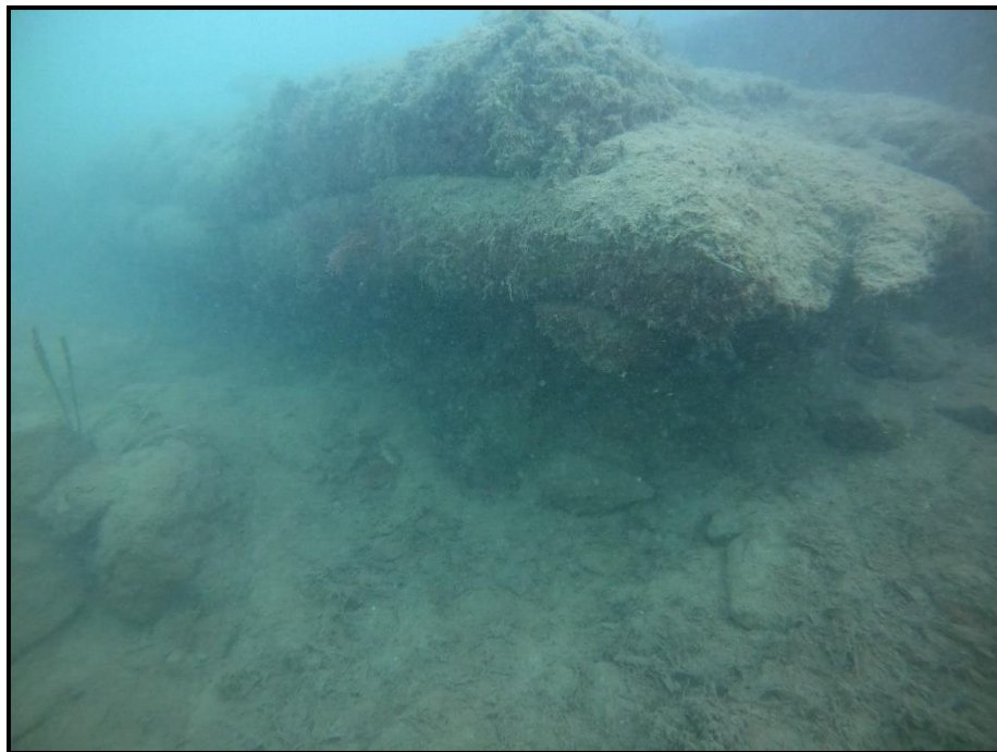
Foto N°5 Descalce en TRAMO 1
