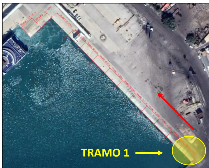
Inicio de inspección. TRAMO 1
