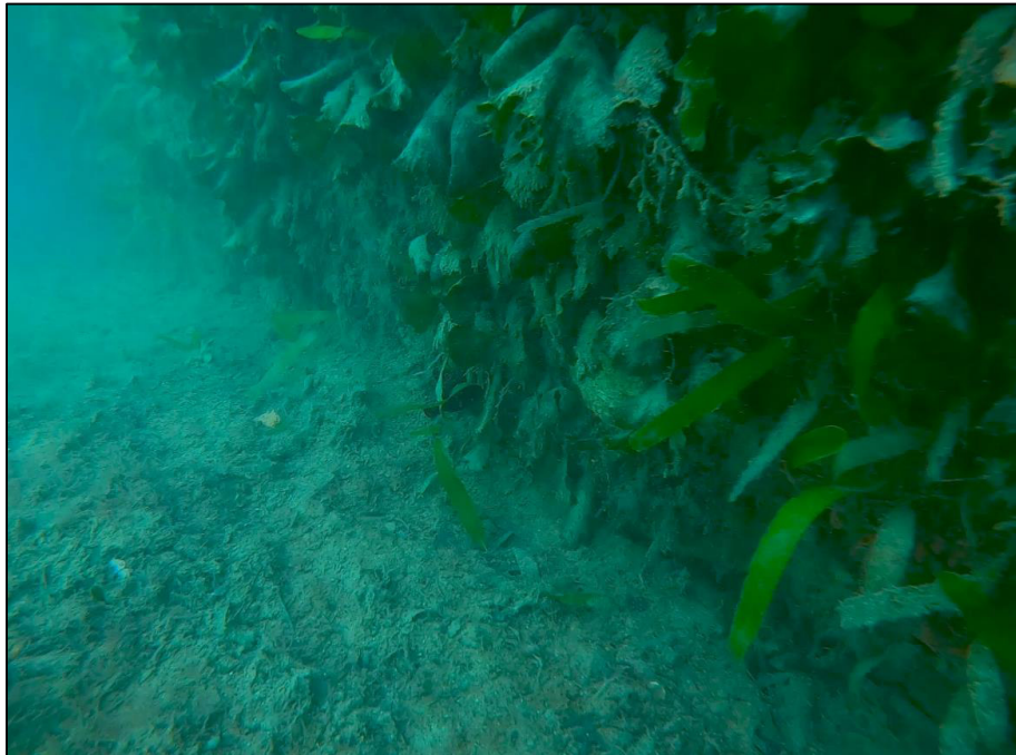
Foto junta de viga de atado con muelle de hormigón en masa TRAMO 8
