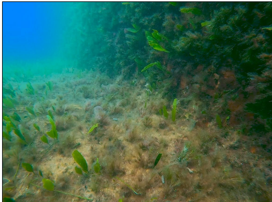
Foto junta de viga de atado con muelle de hormigón en masa TRAMO 13
