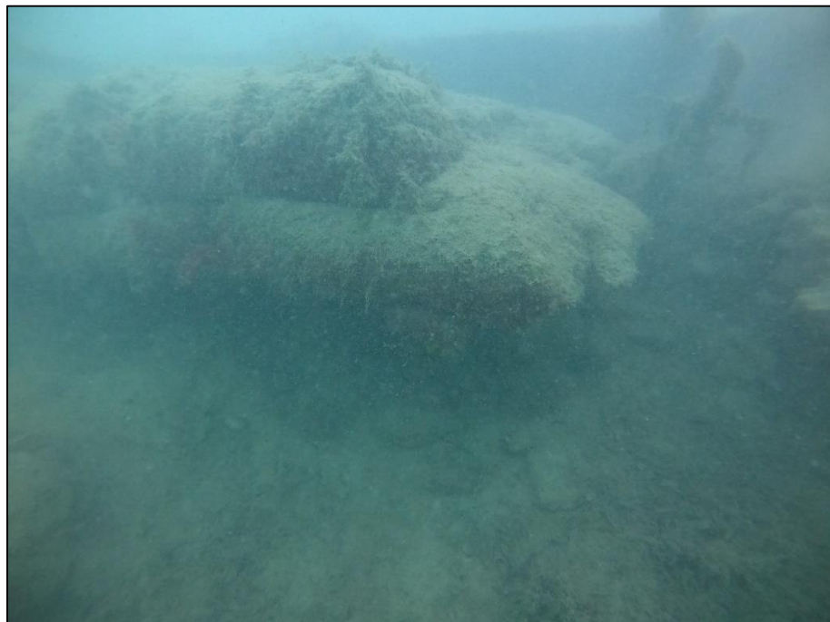
Foto N°7 Descalce en TRAMO 2
