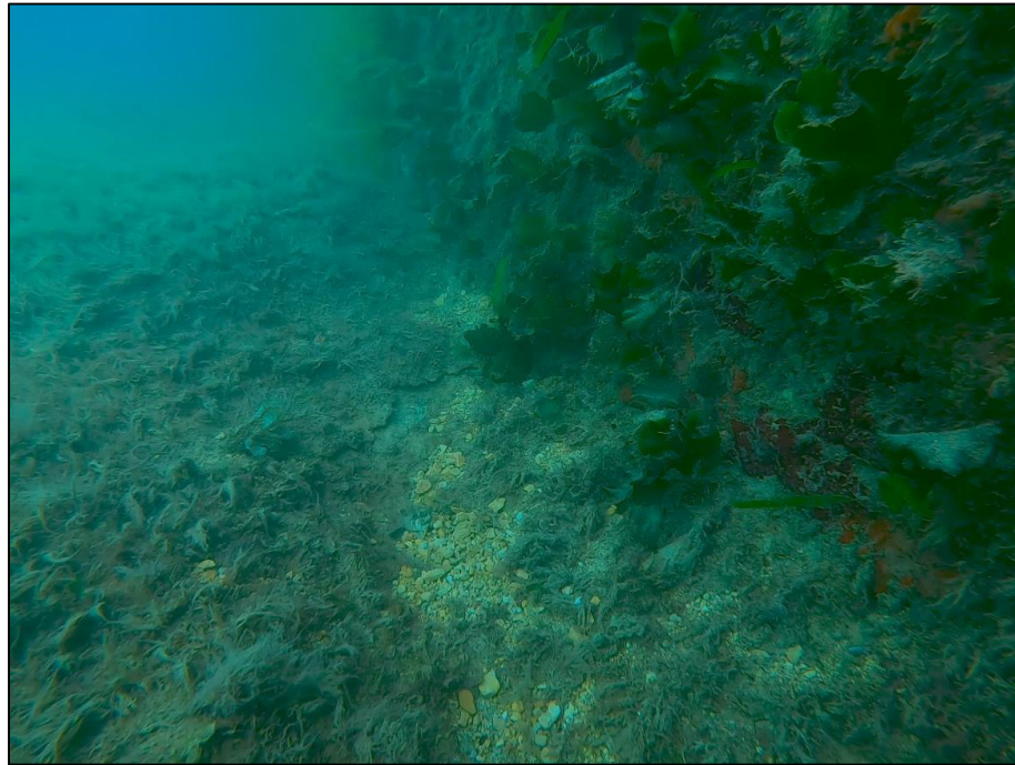
Foto junta de viga de atado con muelle de hormigón en masa TRAMO 10
