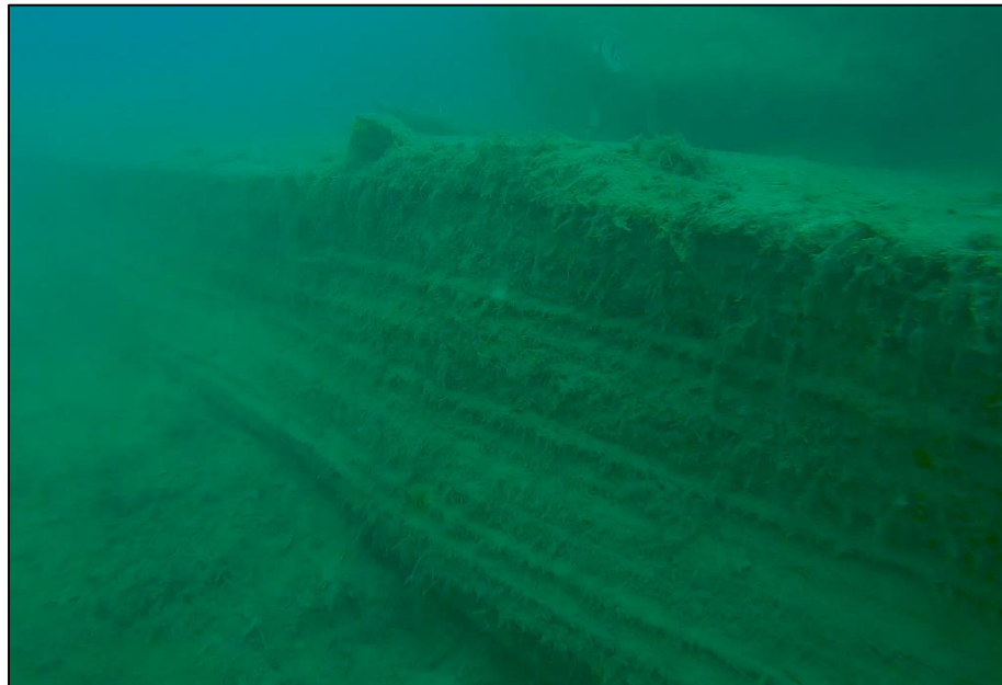
Foto viga de atado inferior en TRAMO 3
