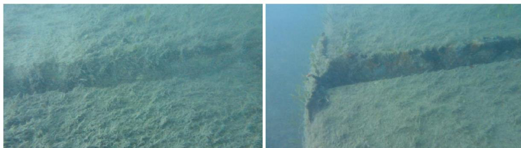
Figura 98. Deslizamientos de 15-20cm.
