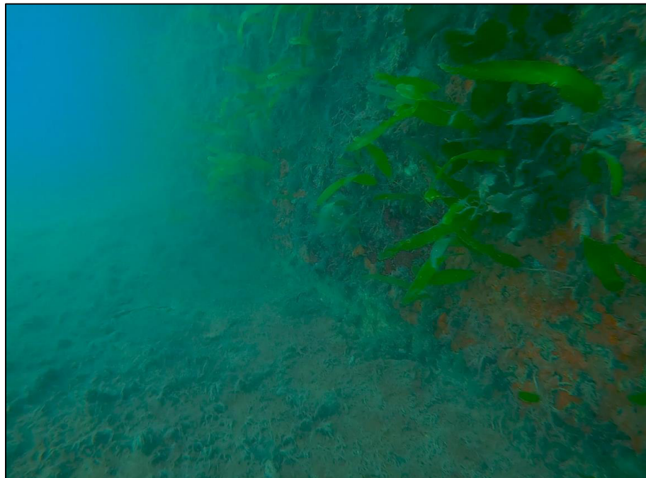
Foto junta de viga de atado con muelle de hormigón en masa TRAMO 9
