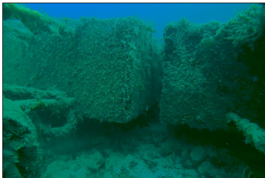
Foto junta de placas prefabricadas en forma de "L" en TRAMO 1
