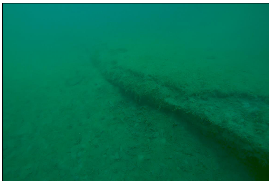
Foto junta de placas prefabricadas en forma de “L” en TRAMO 4
