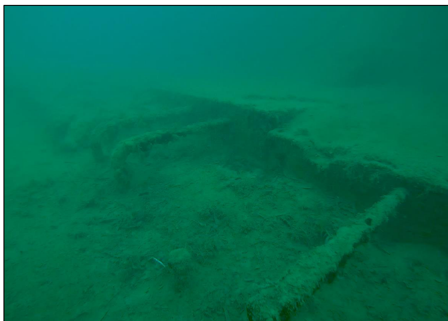
Foto junta de placas prefabricadas en forma de “L” en TRAMO 3
