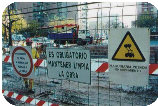
Señalización en zona de obras
