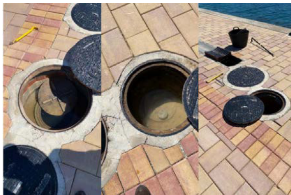
Ilustración 6 Ejemplo de separador de hidrocarburos.
