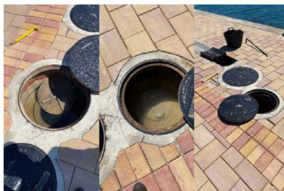
Ilustración 7 Ejemplo de separador de hidrocarburos.
