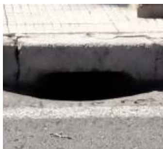
Ilustración 9. Ejemplo de imbornal tipo buzón y pieza de fundición C-250 por la que se propone sustituir .
