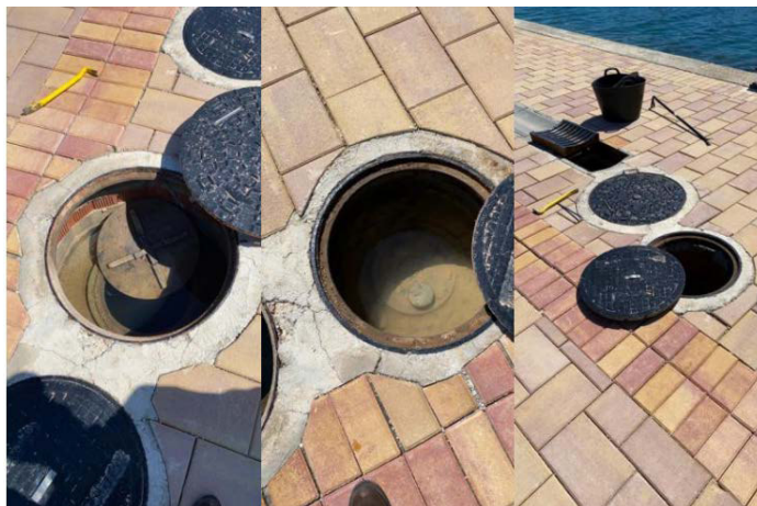
Ilustración 6 Ejemplo de separador de hidrocarburos.
