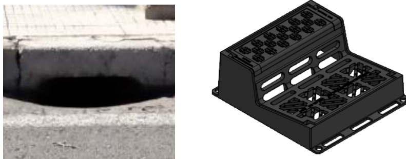
Ilustración 12. Ejemplo de imbornal tipo buzón y pieza de fundición C-250 por la que se propone sustituir .
