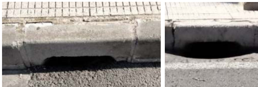
Ilustración 4 Ejemplo de imbornales tipo buzón.
