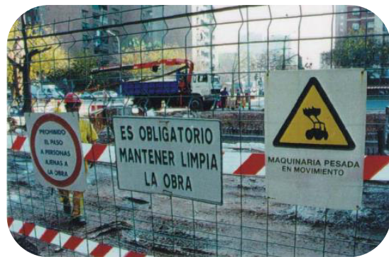
Señalización en zona de obras
