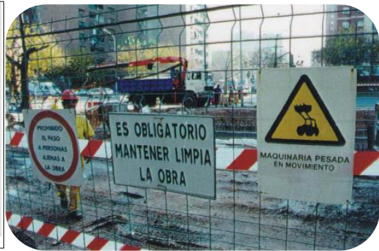
Señalización en zona de obras
