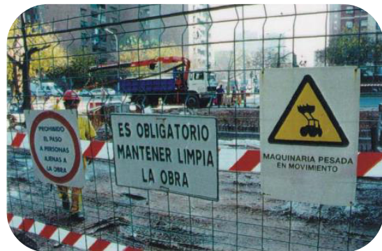
Señalización en zona de obras
