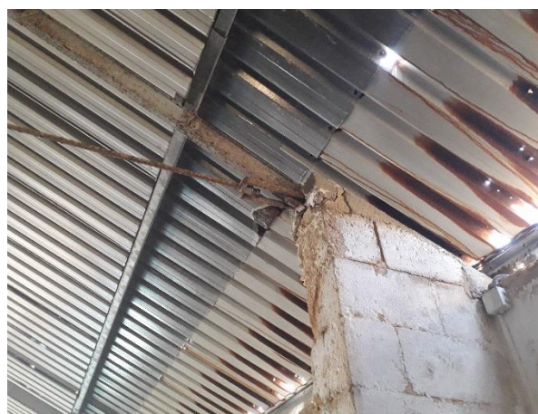
Apoyo de la estructura de la cercha (03/06/2020)
