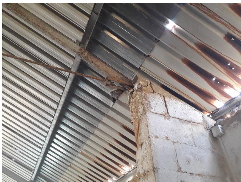
Figura 2.1 Estado actual de la cubierta de la caseta
