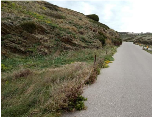
Carretera de acceso Me-3, hacia la fortaleza de La Mola (11/03/2019)
