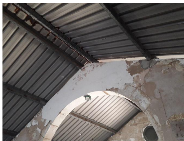
Apoyo de la cubierta en muro (03/06/2020)
