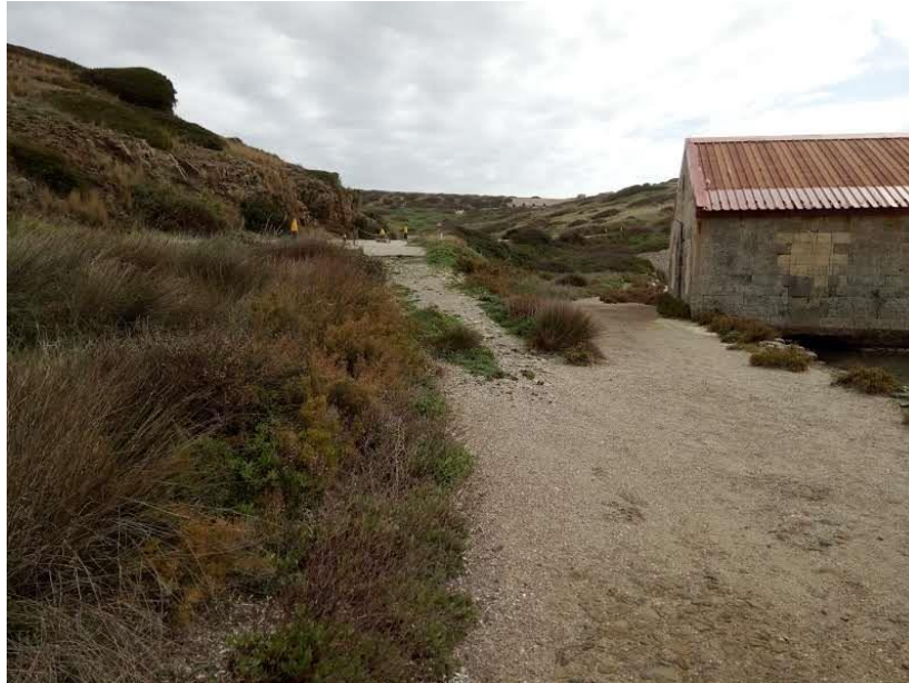
Figura 2.4 Estado actual de camino de acceso a la explanada desde la Me-3
