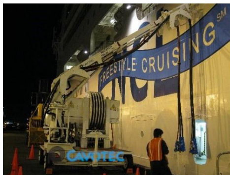
Figura 33. Pasar los cables hacia el barco
