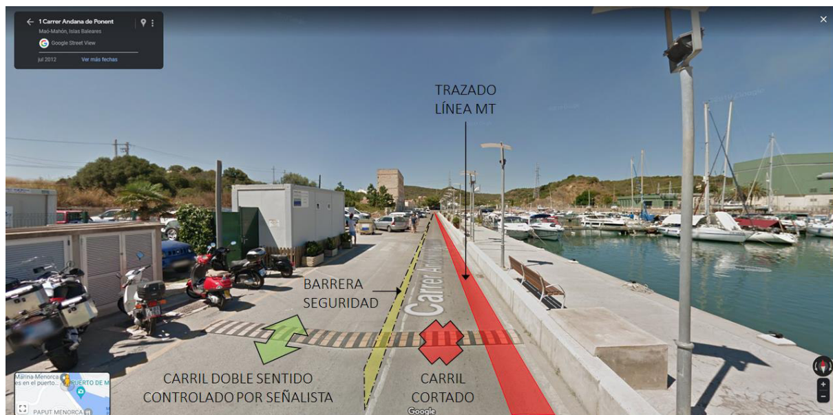
Figura 52. Punto 8 – Calle Andana de Ponent
