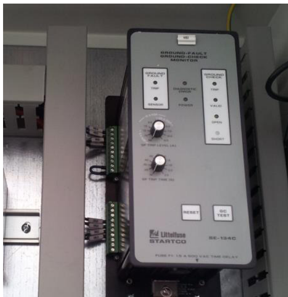
Figura 42. Ejemplo de relé de verificación de puesta a tierra
