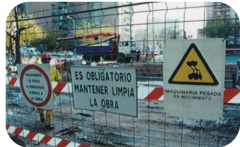
Ejemplo: señalización en zona de obras
