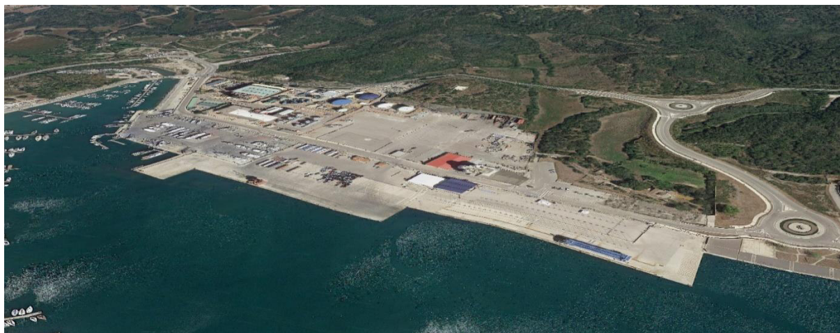
Figura 3. Imagen aérea del Muelle del Cós Nou en el Puerto de Maó
