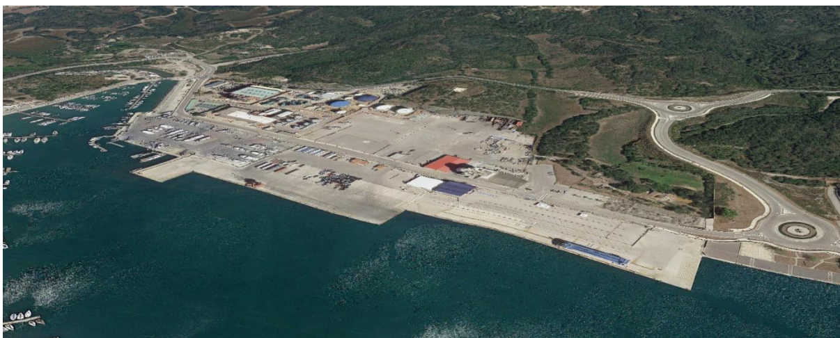
Figura 2. Imagen aérea del Muelle del Cós Nou en el Puerto de Maó
