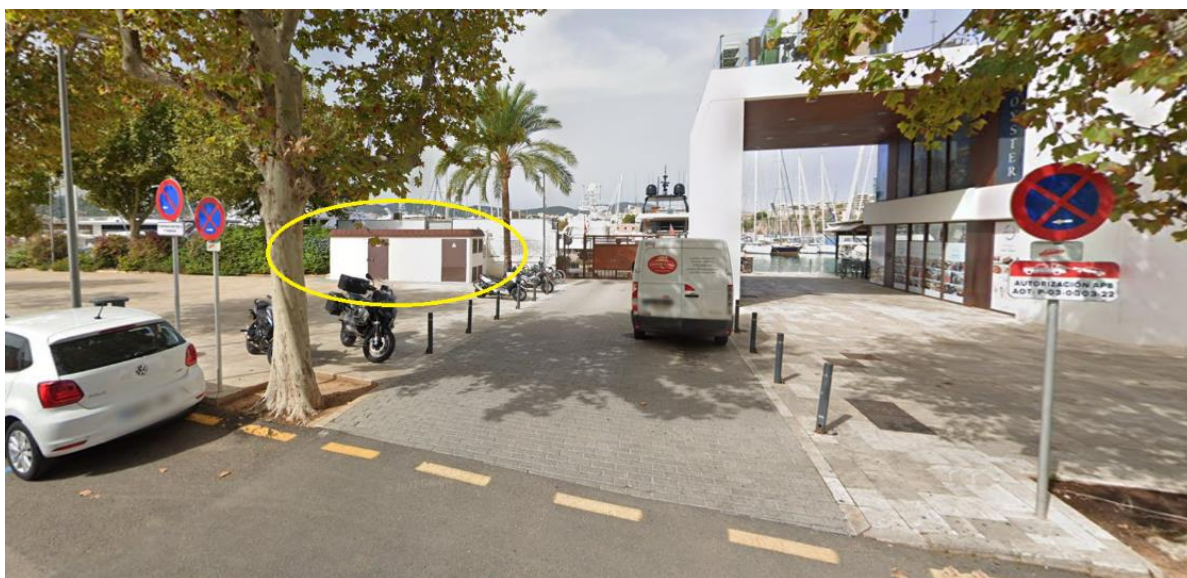
Figura 10. Vista CMM 50948 “CDT NUEVO OBRAS PUERTO” en calle del Muelle Viejo
