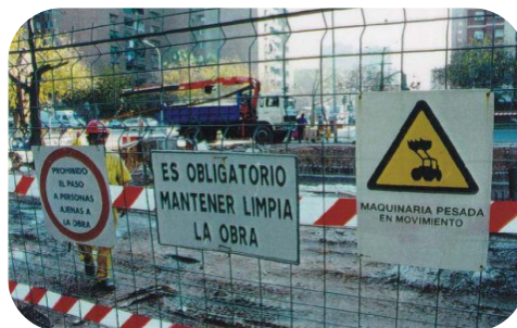
Ejemplo: señalización en zona de obras
