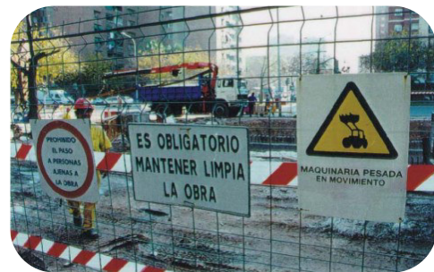
Ejemplo: señalización en zona de obras
