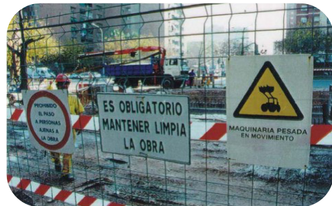
Ejemplo: señalización en zona de obras
