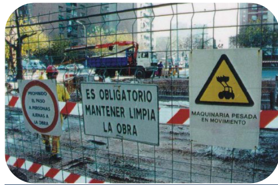
Señalización en zona de obras
