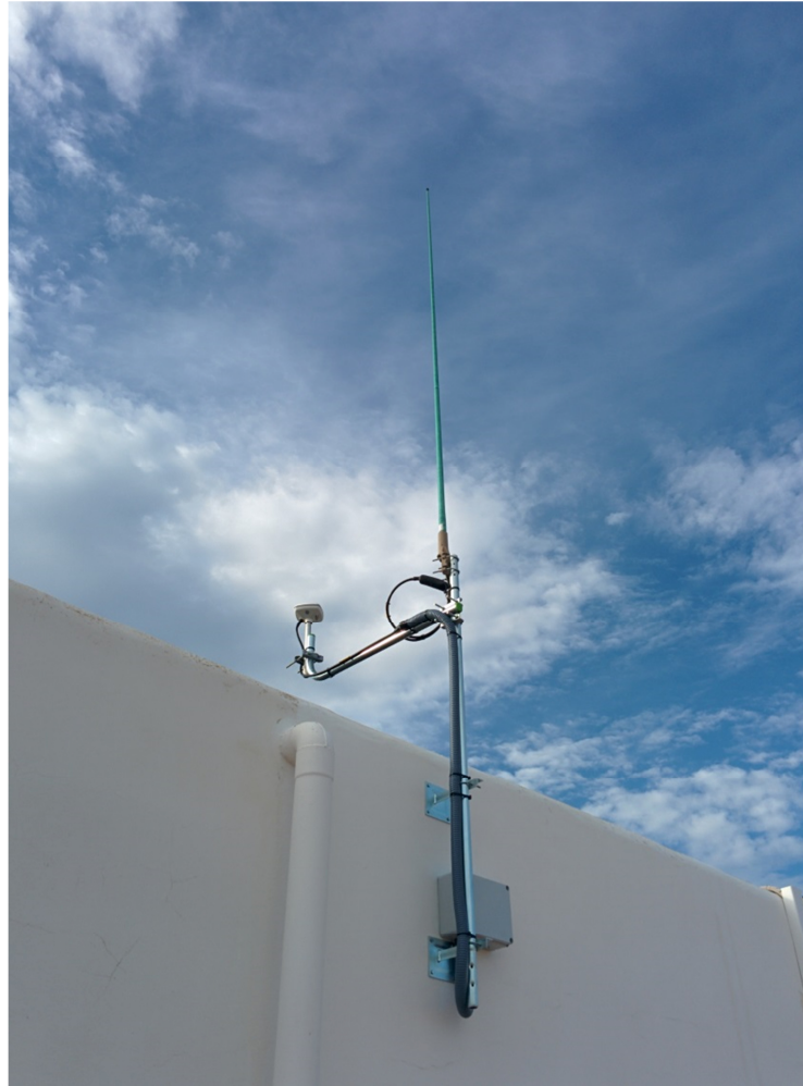
Ilustración 23 - Antenas VHF y GPS en La Savina
