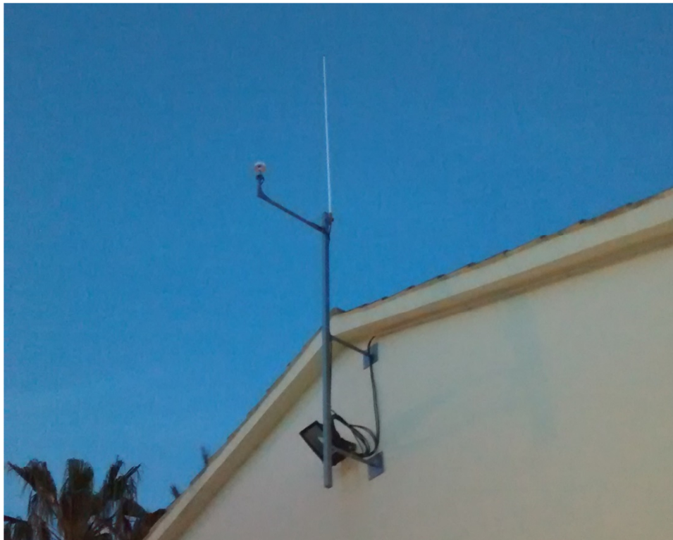
Ilustración 10. Antenas VHF y GPS en Alcudia.
