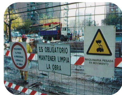
Ejemplo: señalización en zona de obras
