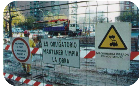
Ejemplo: señalización en zona de obras
