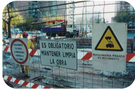
Señalización en zona de obras
