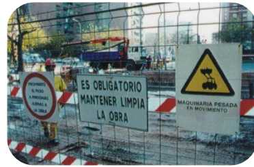
Ejemplo: señalización en zona de obras
