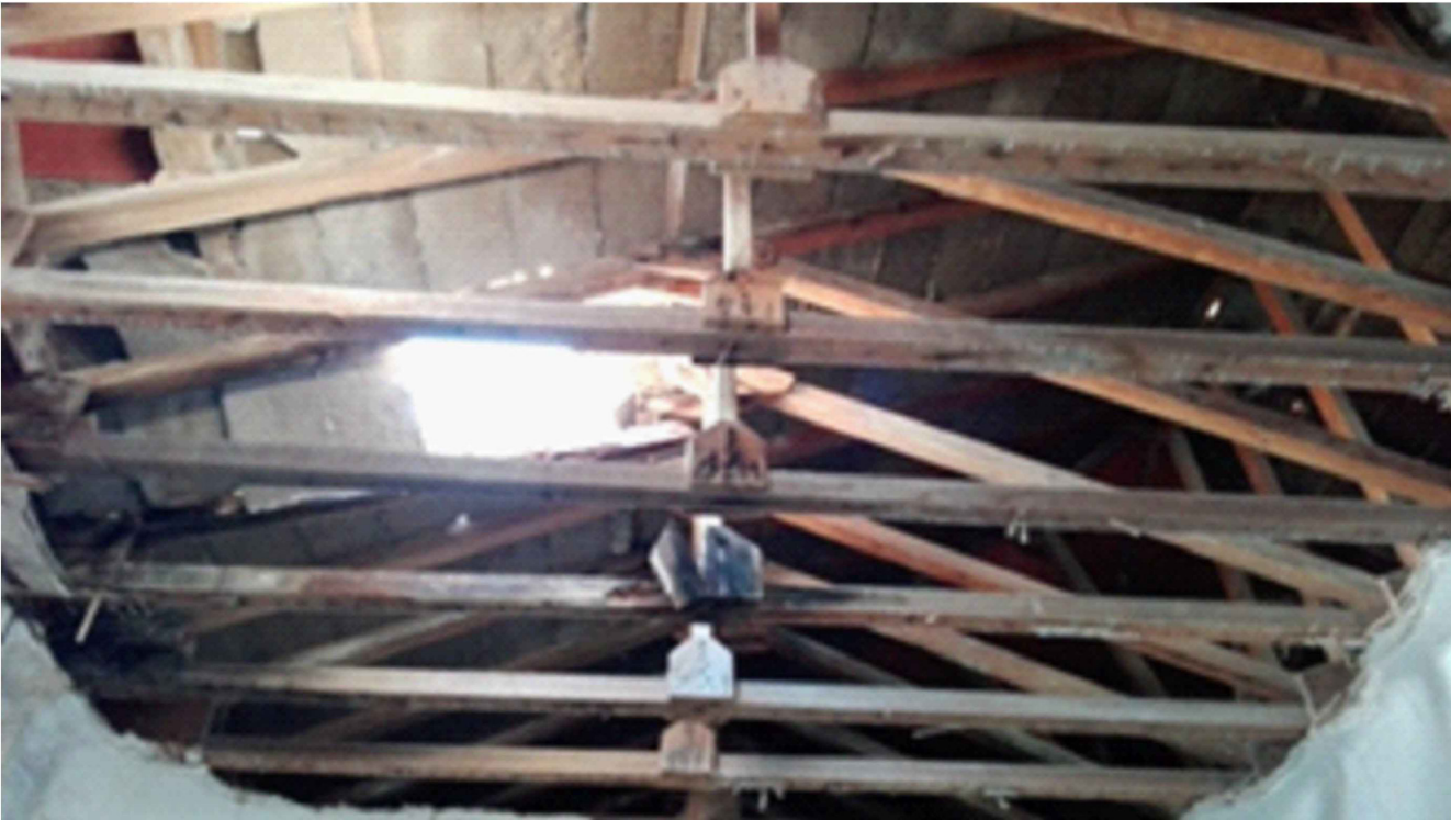
ESTRUCTURA DE MADERA EXISTENTE
