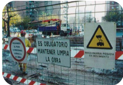
Ejemplo: señalización en zona de obras
