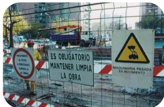
Señalización en zona de obras
