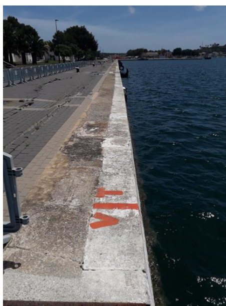
Figura 2 Estado actual del muelle
