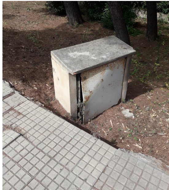
Imagen 9. Hornacina y armario para agua en CC. AA.
