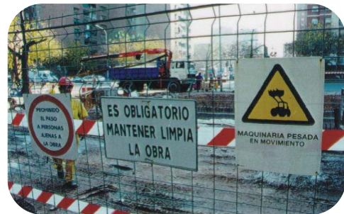
Ejemplo: señalización en zona de obras
