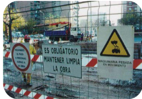
Ejemplo: señalización en zona de obras
