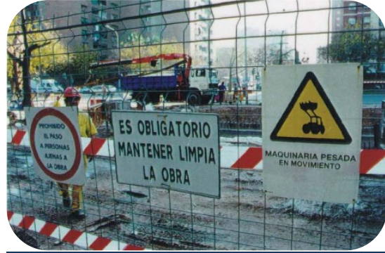
Señalización en zona de obras
