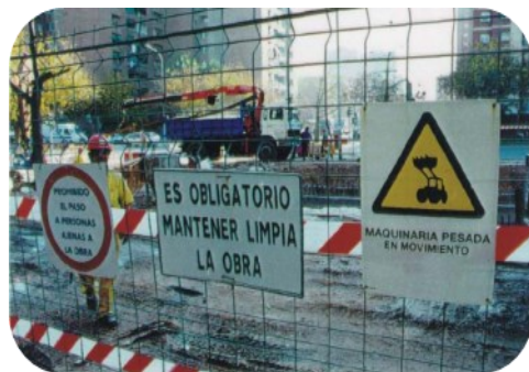
Ejemplo: señalización en zona de obras
