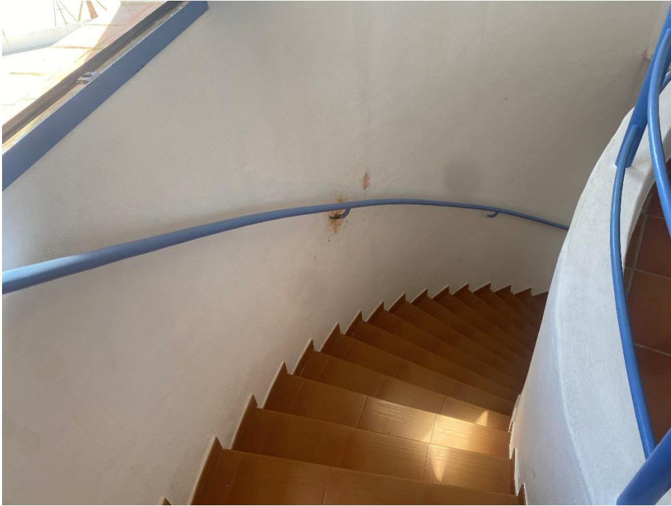
Ilustración 6 Acceso con escaleras a la segunda planta.
