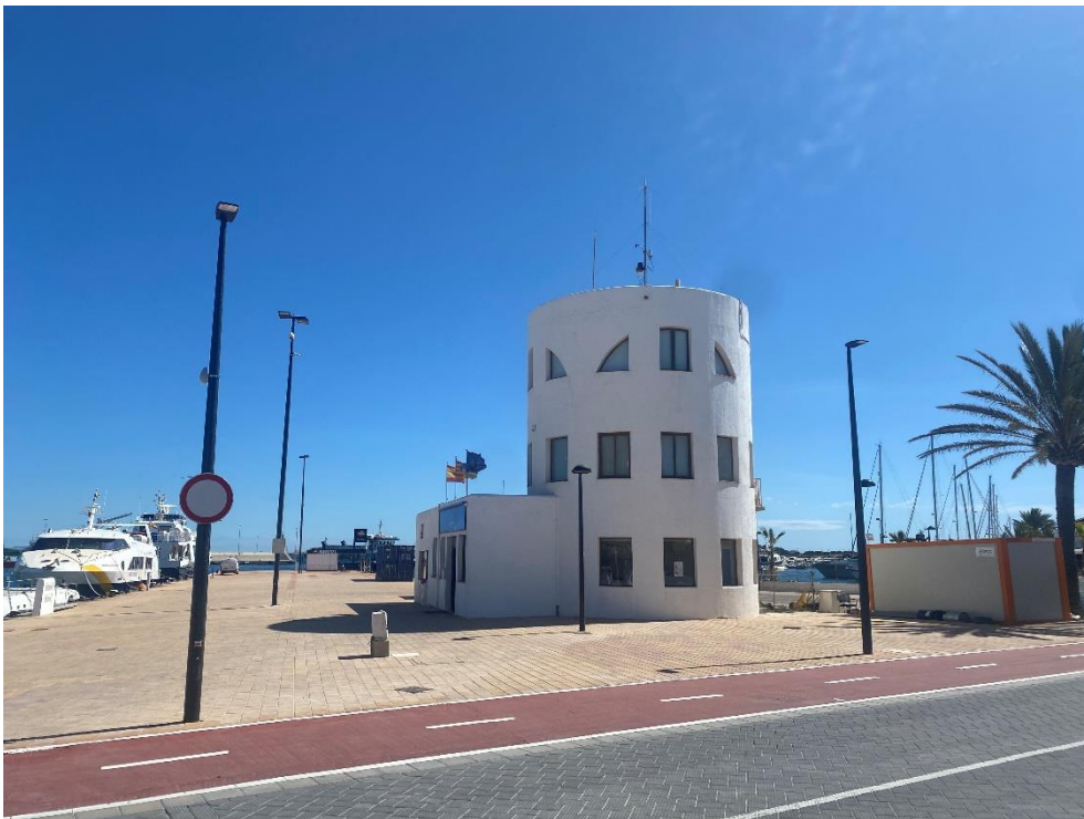
Ilustración 3 Edificio de capitania Puerto de la Savina.
