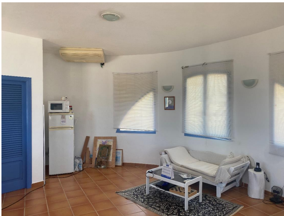
Ilustración 10 Zona donde se va a instalar el aseo, se deberá desplazar el equipo de aire acondicionado.
