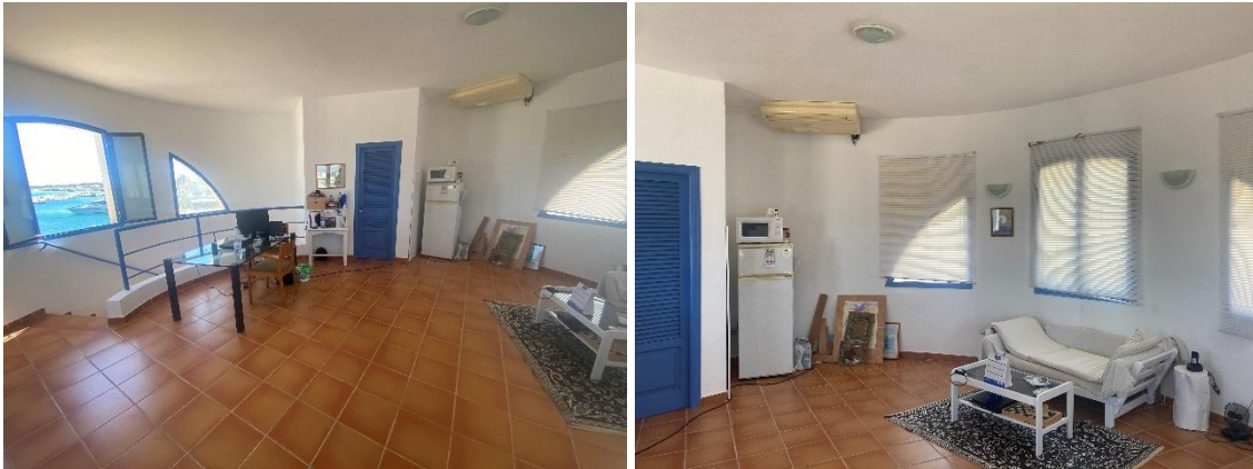
Ilustración 3 Estado actual de la primera planta del edificio de capitanía.
