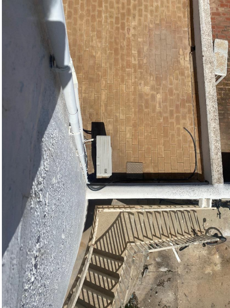
Ilustración 13 Conductos para instalación de aire acondicionado que ocultaran dentro de la fachada aprovechando la ejecución de la bajante del nuevo aseo.
