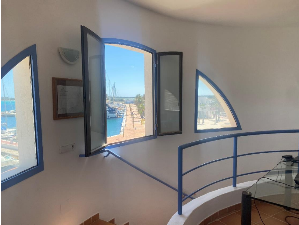
Ilustración 8 Acceso a segunda planta y murete con barandilla de seguridad
