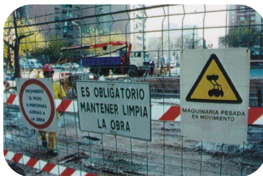
Señalización en zona de obras
