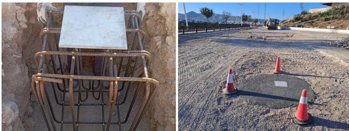
Ilustración 6 Cimentaciones ejecutadas para estructura de sombras
