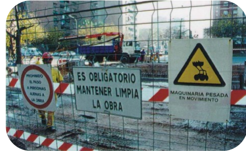
Ejemplo: señalización en zona de obras
