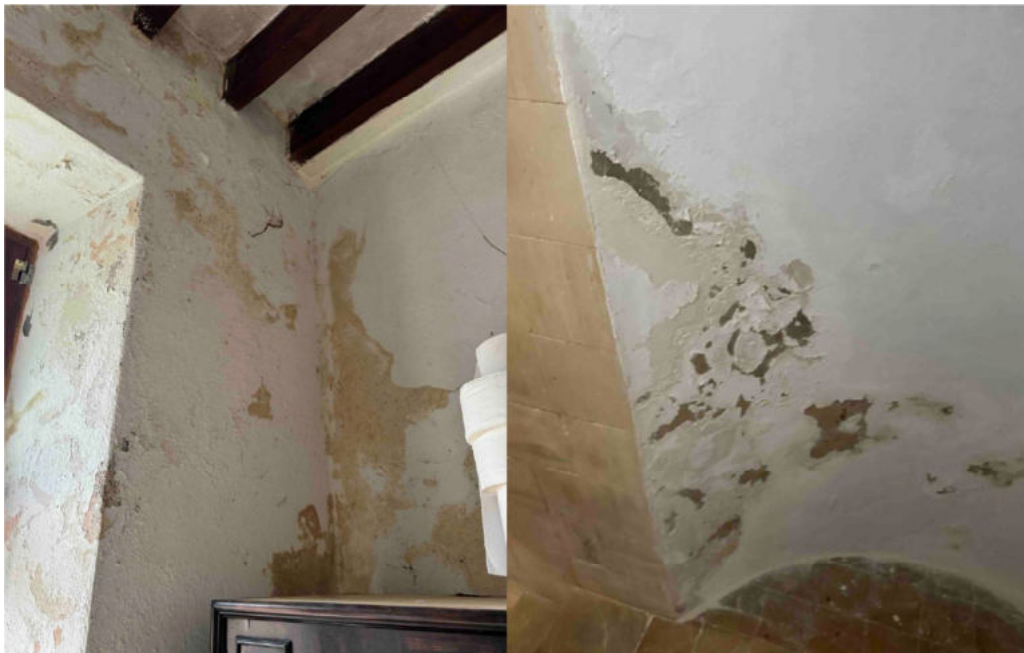
Il·lustració 5 Estado paramentos
