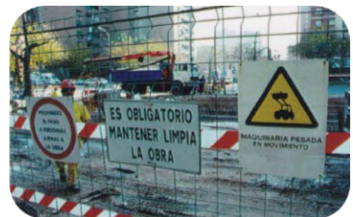
Ejemplo: señalización en zona de obras
