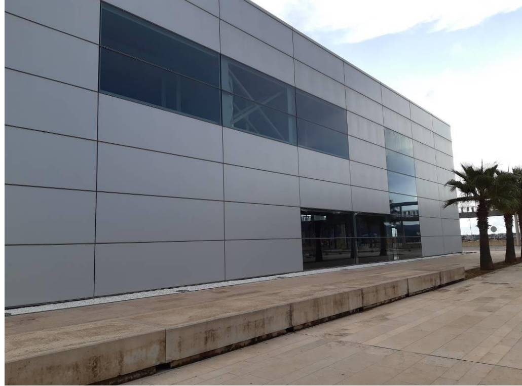
Paneles Alucobond de 5 metros de longitud y elementos de cristal
