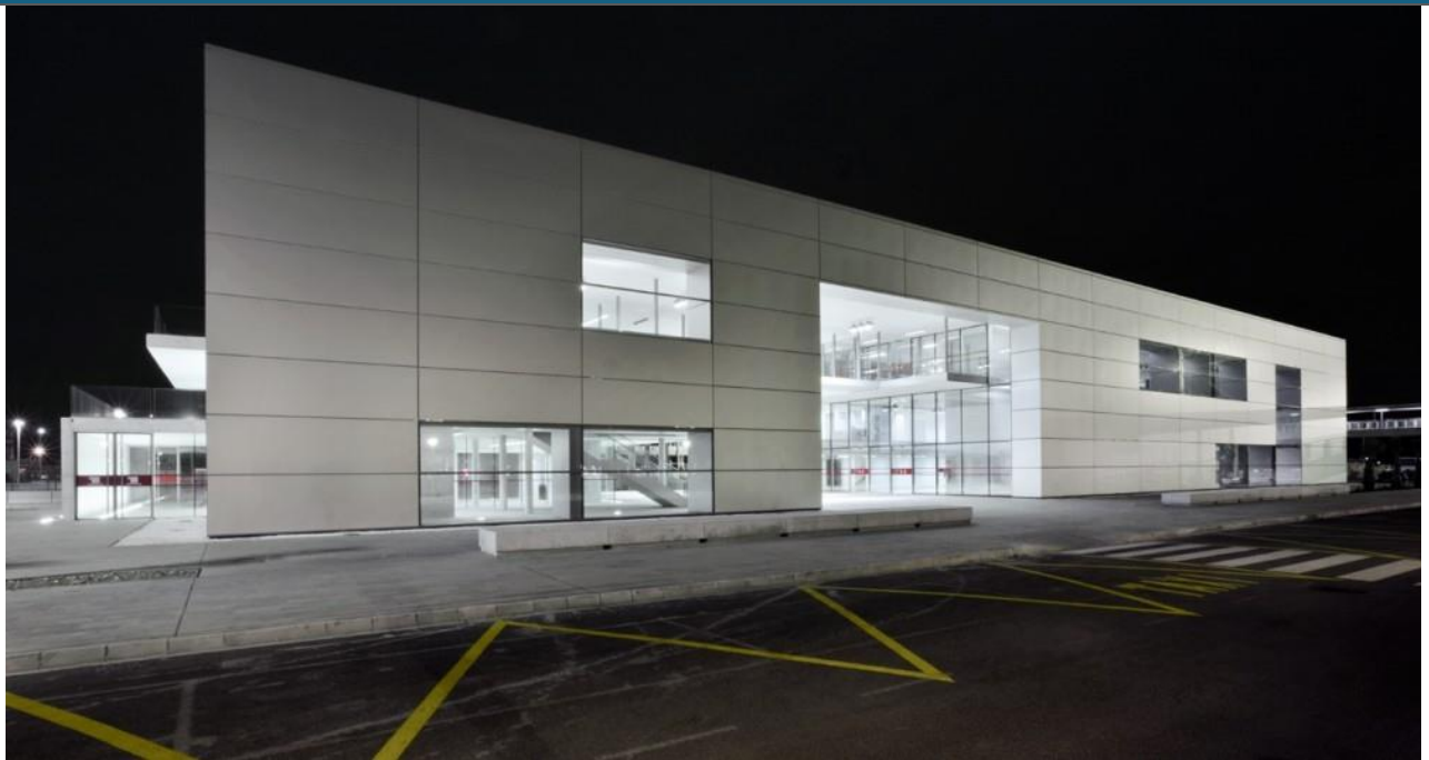
Fachada principal sur
