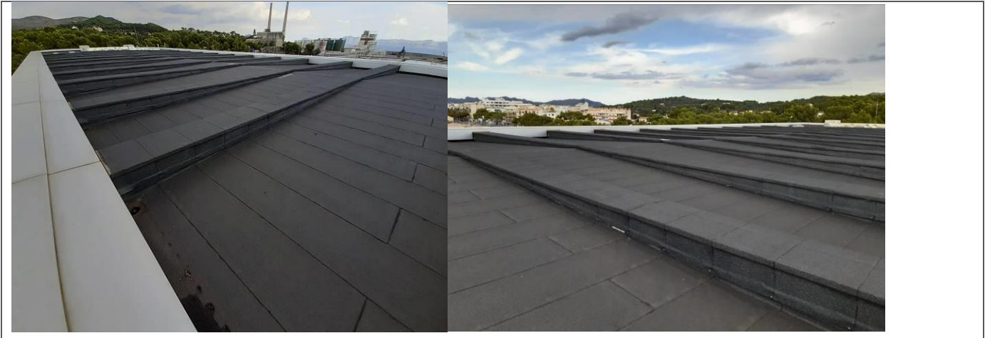
Paneles Alucobond de 5 metros de longitud y elementos de cristal
