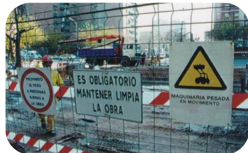
Ejemplo: señalización en zona de obras
