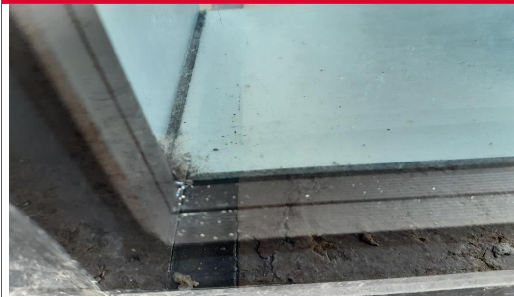
Paneles de acristalamiento con doble cámara de aire
