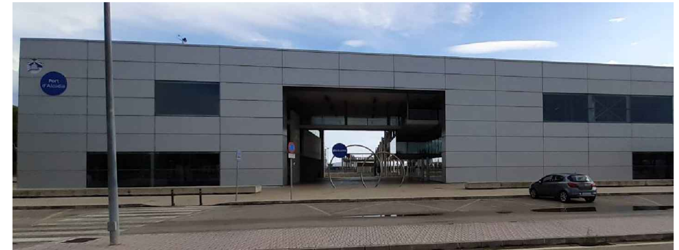
ESTACIÓN MARÍTIMA LA ALCUDIA S/E
