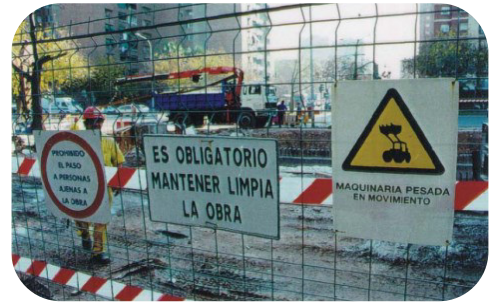
Ejemplo: señalización en zona de obras
