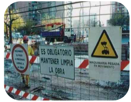
Ejemplo: señalización en zona de obras
