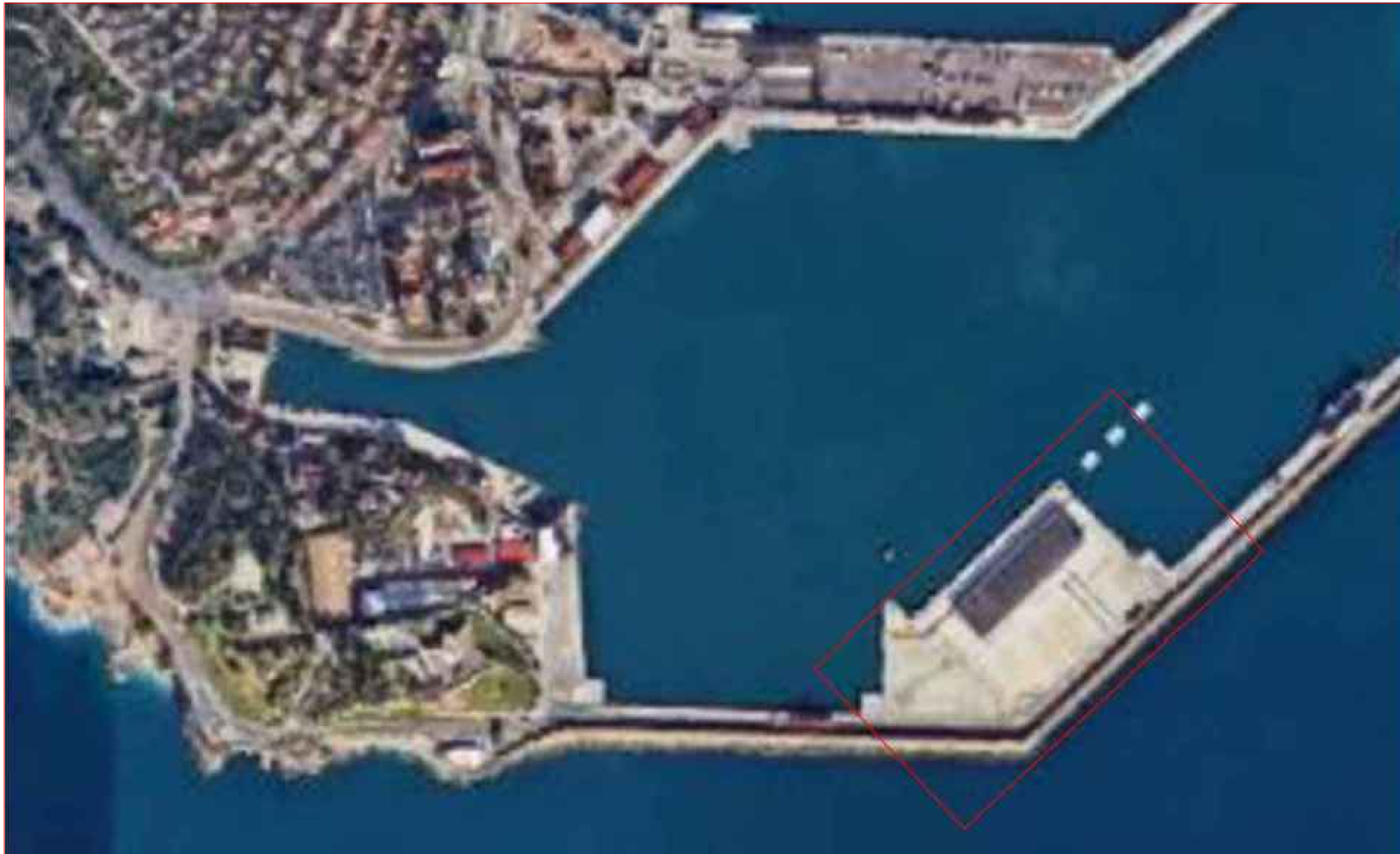
ESTACIÓN MARÍTIMA 6 S/E
