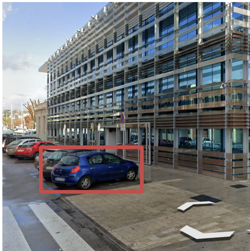
Figura 2: situación de donde se ubicaría el grupo electrógeno de alquiler
