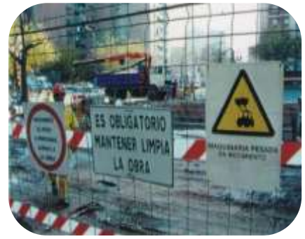
Ejemplo: señalización en zona de obras
