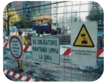
Ejemplo: señalización en zona de obras
