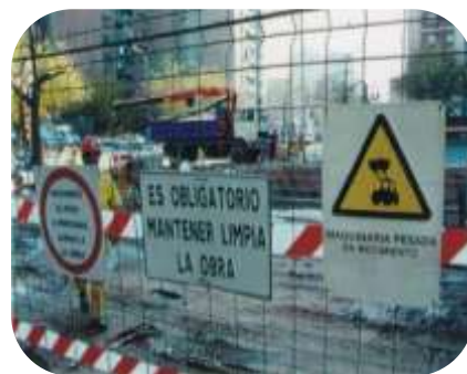
Ejemplo: señalización en zona de obras
