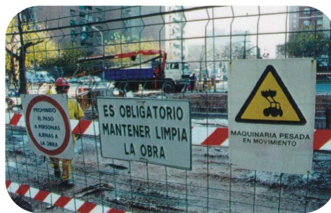
Ejemplo: señalización en zona de obras
