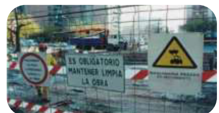
Ejemplo: señalización en zona de obras
