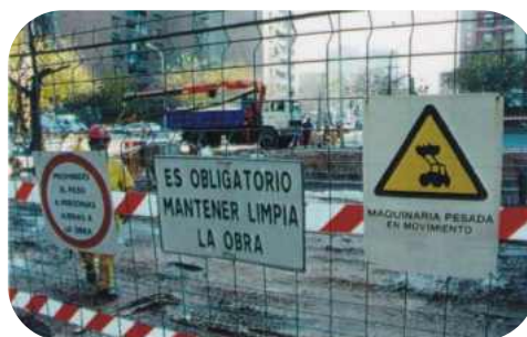
Ejemplo: señalización en zona de obras
