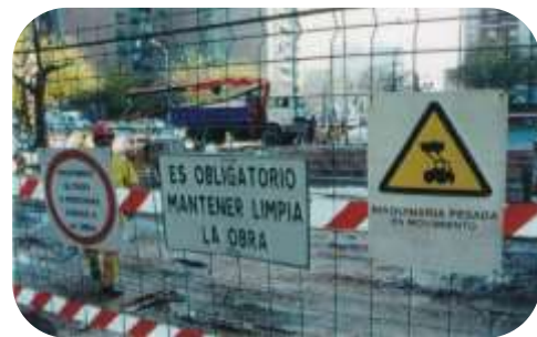
Ejemplo: señalización en zona de obras
