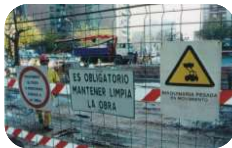
Ejemplo: señalización en zona de obras
