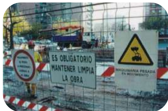
Señalización en zona de obras
