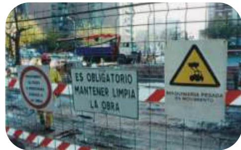
Ejemplo: señalización en zona de obras
