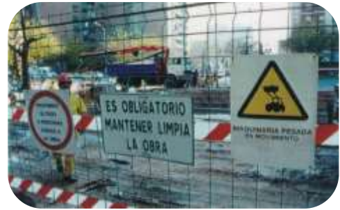
Ejemplo: señalización en zona de obras
