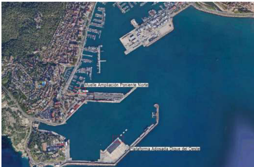
Puerto de Palma / Muelle de Ampliación de Poniente Norte – Plataforma Adosada Dique del Oeste
