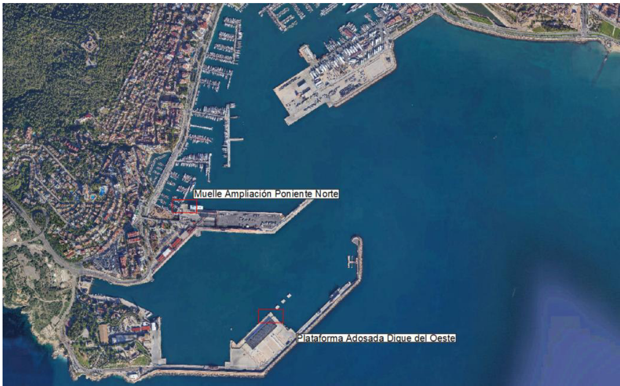
Figura 2. Puerto de Palma / Muelle de Ampliación de Poniente Norte – Plataforma Adosada Dique del Oeste
