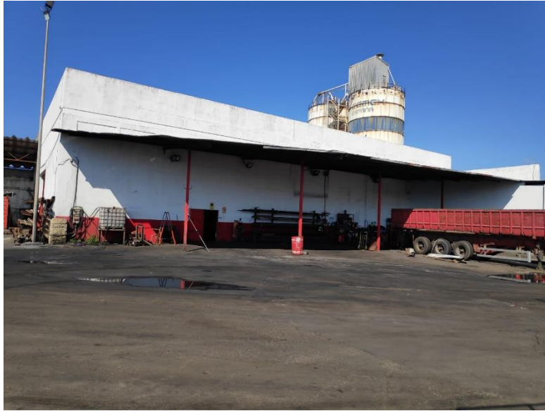
Ilustración 18 Parte trasera de almacén
