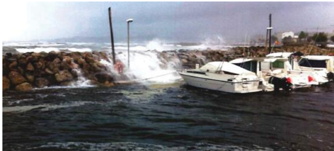
Figura 1. Ejemplo de rebase del dique de poniente durante un temporal (Fuente: Club Náutico)
