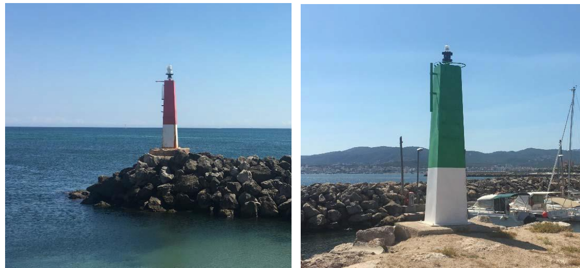
Figura 2. Detalle de las dos balizas del Puerto del Molinar
