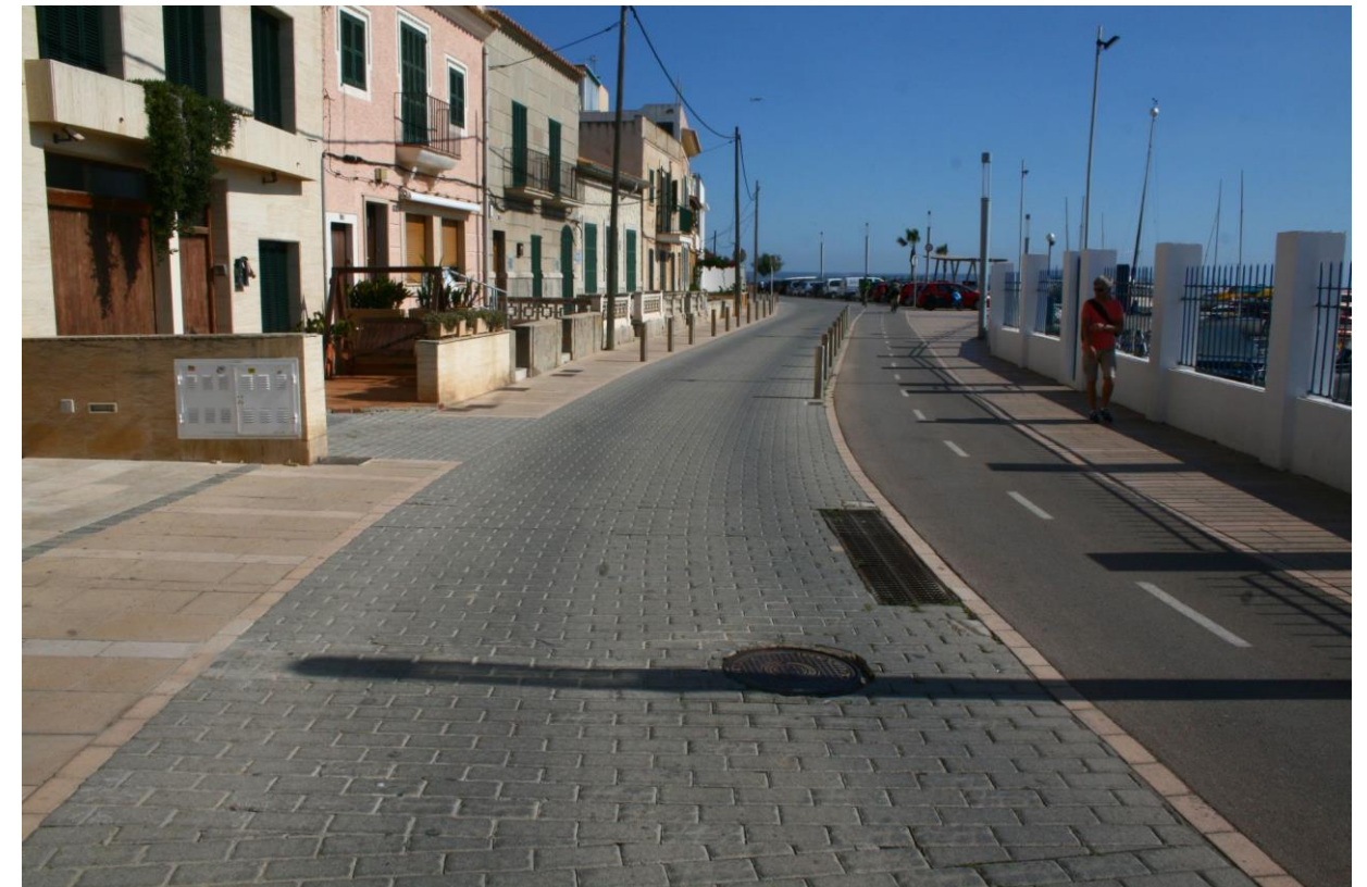
Figura 5. Vista de la calle Vicari Joaquim Fuster.
