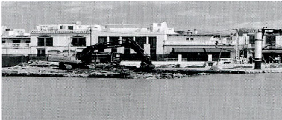
Fotografía 2. Grúa existente en muelle a demoler
