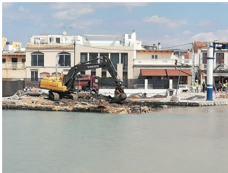
Fotografía 2. Grúa existente en muelle a demoler
